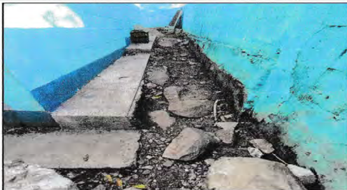
Foto1: Reparación de piso de torta de concreto
