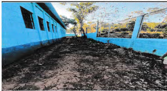
Foto 2: Reparación piso de torta de concreto
